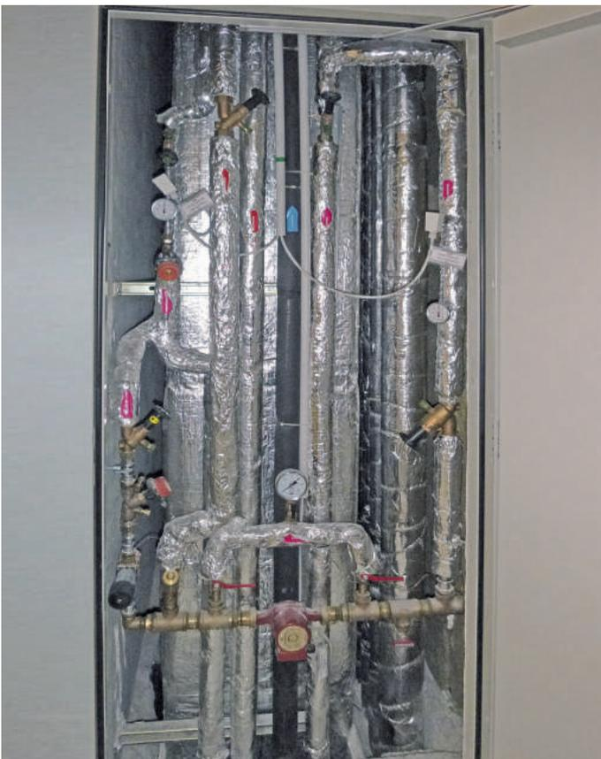
**Vorher:** Mangelhafter Installationsschacht, keine korrekte brandschutztechnische geschossweise Abschottung.
