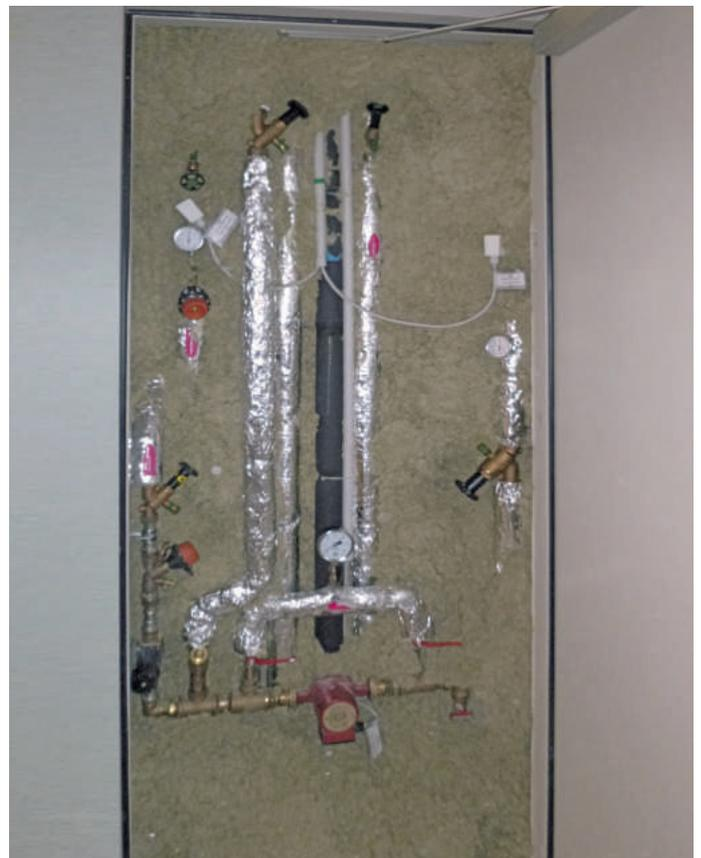
**Nachher:** Höchste Sicherheit durch die komplette Schachtverfüllung mit dem System Firesafe.
